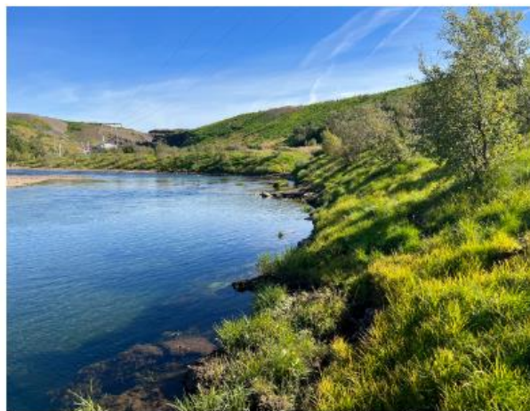
Sjálfbærar bakkavarnir í Andakílsá haustið eftir að framkvæmdum lauk. Gróðurorturnar farnar að vaxa vel og öll birkitré og víðirunnar lifandi og gróskumikil.
